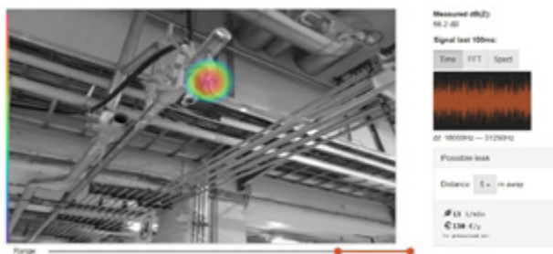
Obrázek 8: Ukázka netěsnosti rozvodu stlačeného vzduchu včetně kvantifikace
