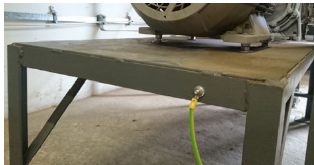
Obrázek 1: Příklad málo tuhé a nevhodně navržené konstrukce upevnění stroje
